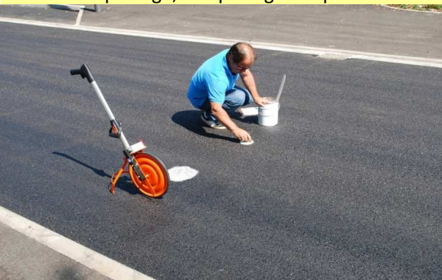
Test de perméabilité tout les 50 mètres
