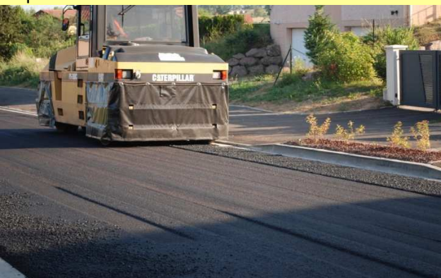
1 er passage, compactage "au pneu"
