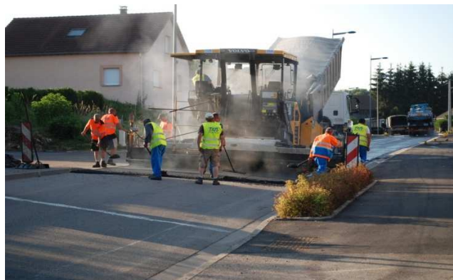
07h35, démarrage de la pose de l'enrobé
