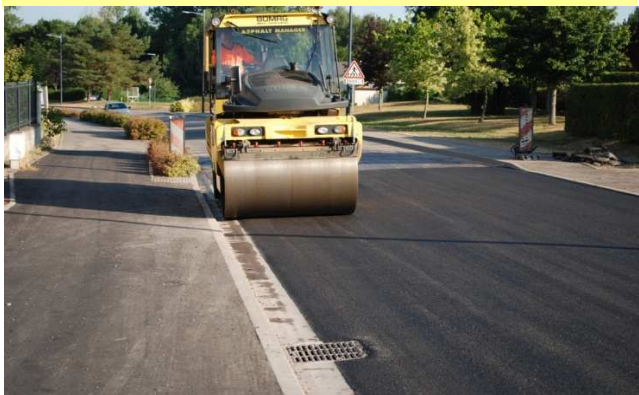
2 ème passage, compactage "au cylindre"
